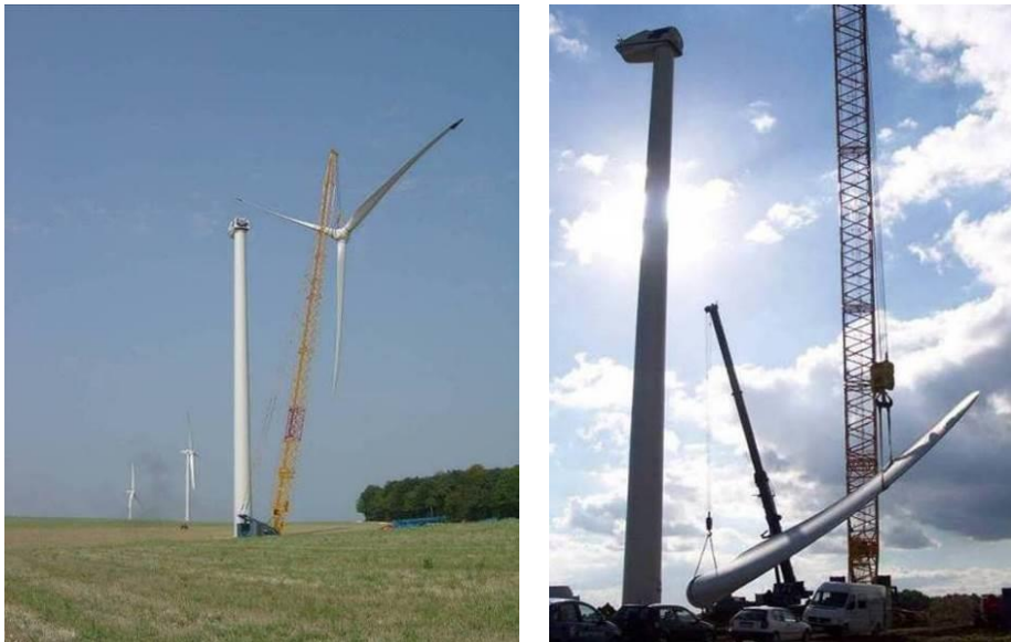
Figure 15 : Grue de montage et élevage du rotor
