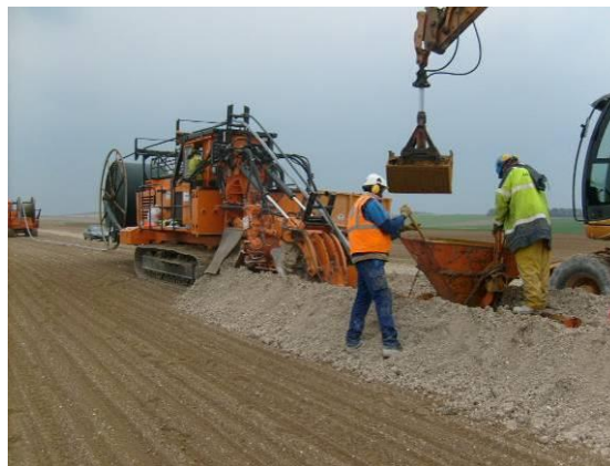
Figure 17 : Tranchée pour l'enfouissement des câbles électriques
